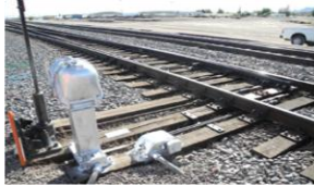
Mantenimiento de vía (Ferrovalle)
